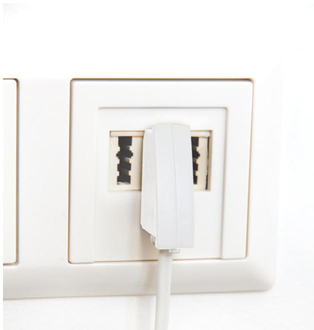
Eine F-kodierte TAE-Auslassdose sowie ein herkömmliches Telefonkabel reichen aus, um die devolo Giga Bridge mit dem NT/ONT zu verbinden. Der TAE-Stecker nutzt die Pins 1/2, sodass der SISO-Modus der Giga Bridge genutzt wird.
